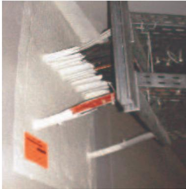
Die Anforderung an durchführende Kabel und Kabeltassen ist, dass diese im Brandfall die Weichabschottung durch Verwindungskräfte nicht zerstören. Dabei können die Kabeltassen im Schottbereich abgeschnitten werden oder müssen verwindungsfrei im Bereich von max. 600 mm vor und nach dem Schott abgehängt werden.
